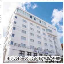
ホテルピースランド石垣島/外観
